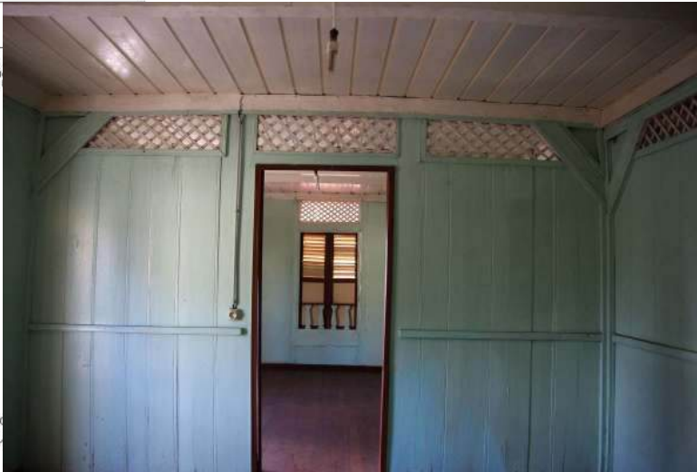
(cloisons de bois avec lisse raidisseuse à mi-hauteur)
