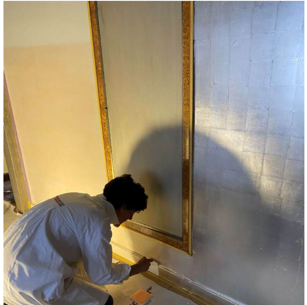
Chantier Hôtel Wielemans
