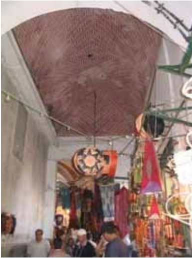
Voûte souk El Attarine: avant et après travaux
