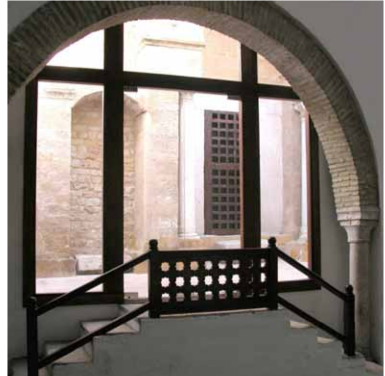
Restauration de la façade Hafside au Souk El Q'mach
