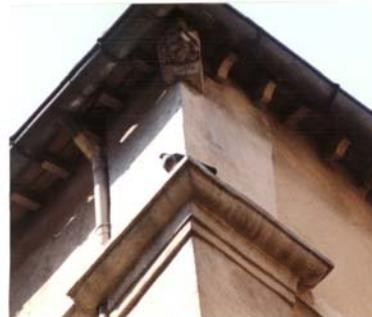
Arêtier et pilastre d'angle
